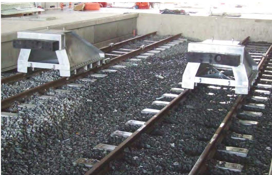
Масса состава: 450 тонн. Скорость удара: 15 км/ч. Оснащен 8 парами фрикционных башмаков.
