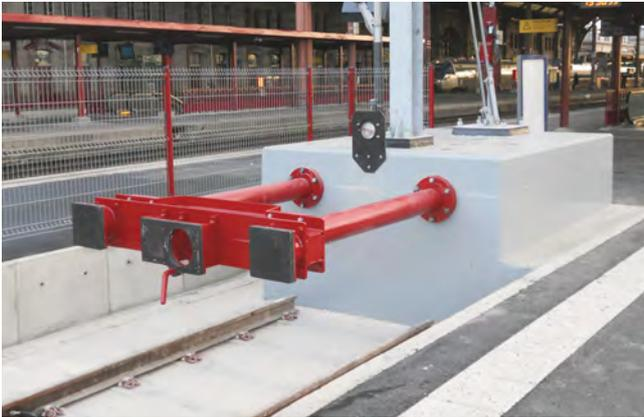
Üblicherweise auf Metro- und Hauptstrecken eingesetzt – für Mitten- und Seitenaufprall konzipiert. Betonfundamentsockel mit Oleo-Hydraulikeinheiten (zwei Oleo Typ 718 – wiederherstellbare Einfederung: 1800 mm). Zugmasse: 267 Tonnen, Aufprallgeschwindigkeit: 12 km/h, Aufpralleistung: 2016 kJ, Einbaulänge: 5,5 m.
