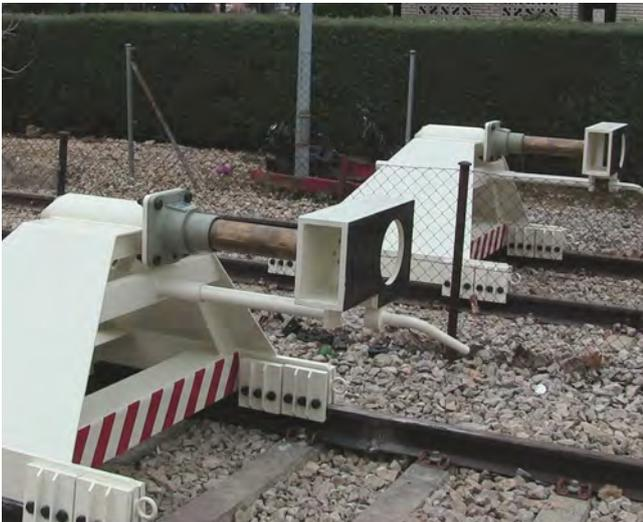
Im Einsatz auf Metro-Madrid Zügen Serie 5000, 6000, 7000, 8000 und 9000. Mit Oleo Hydraulikeinheit (einmal Typ 9 – wiederherstellbare Einfederung 400 mm). Massenbereich der Züge zwischen 163 Tonnen und 216 Tonnen. Aufprallgeschwindigkeit maximal 15 km/h. Einbaulänge: 7,1 Meter. Aufpralleistung 224 kJ.
