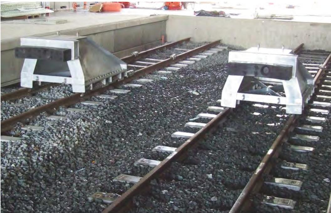
Zugmasse: 450 Tonnen Aufprallgeschwindigkeit 15 km/h, mit acht Paar Bremschuhen mit einer Einbaulänge von 15 m ausgestattet.
