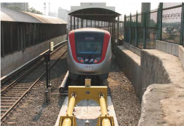
Üblicherweise auf Metro- und Hauptstrecken eingesetzt – für Mitten- und Seitenaufprall konzipiert. Betonfundamentsockel mit Oleo-Hydraulikeinheiten (zwei Oleo Typ 730 – wiederherstellbare Einfederung 3000mm). Zugmasse: 510 Tonnen, Aufprallgeschwindigkeit: 12 km/h, Einbaulänge: 9,5 Meter, Aufpralleistung 3360 kJ.
