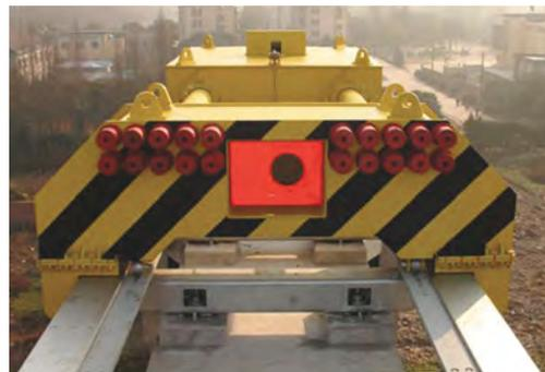
Üblicherweise auf Teststrecken mit geringen Geschwindigkeiten eingesetzt – für Mitten- und Seitenaufprall konzipiert. Festprellböcke mit Oleo-Hydraulikeinheiten (zwei Oleo Typ 718 – wiederherstellbare Einfederung 1800 mm). Einbaulänge: 5,5 m, Aufpralleistung 2016 kJ.
