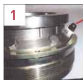
1 Tampa e anilha antes da instalação
